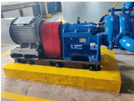
噪声泵基础减震
