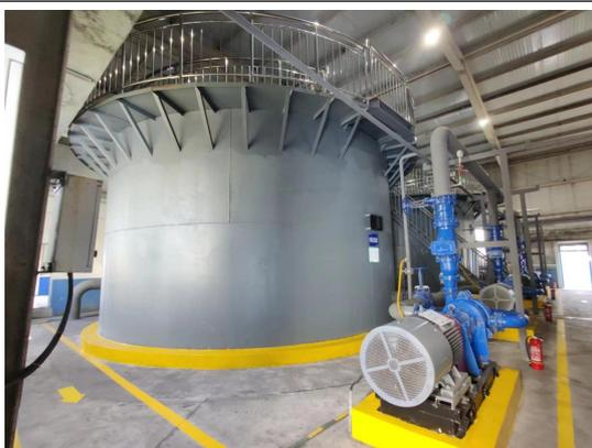
污泥浓缩罐噪声基础减震
