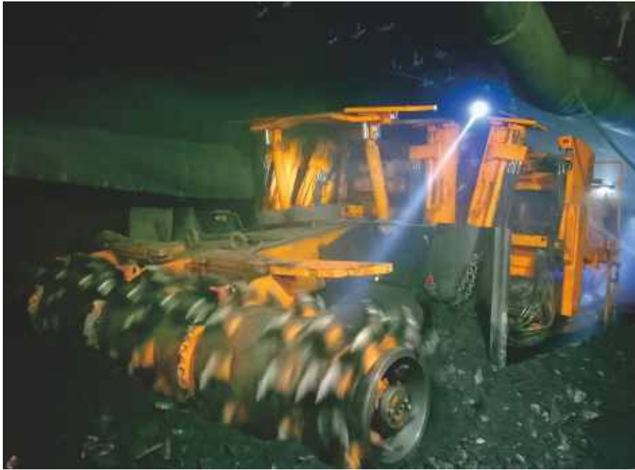
各矿井引进快速掘锚装备提升单进水平
