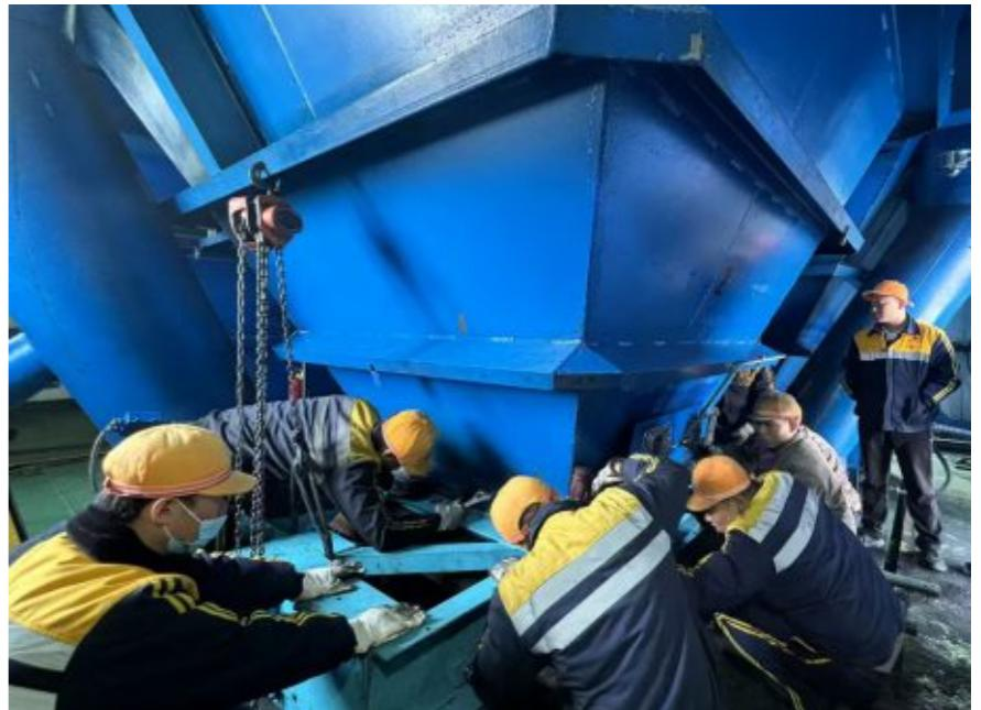
放煤装车工在施工负责人的带领下，采用定制滑轮组和倒链进行接力运输。经过2个半小时的努力，闸板支架成功移出。
