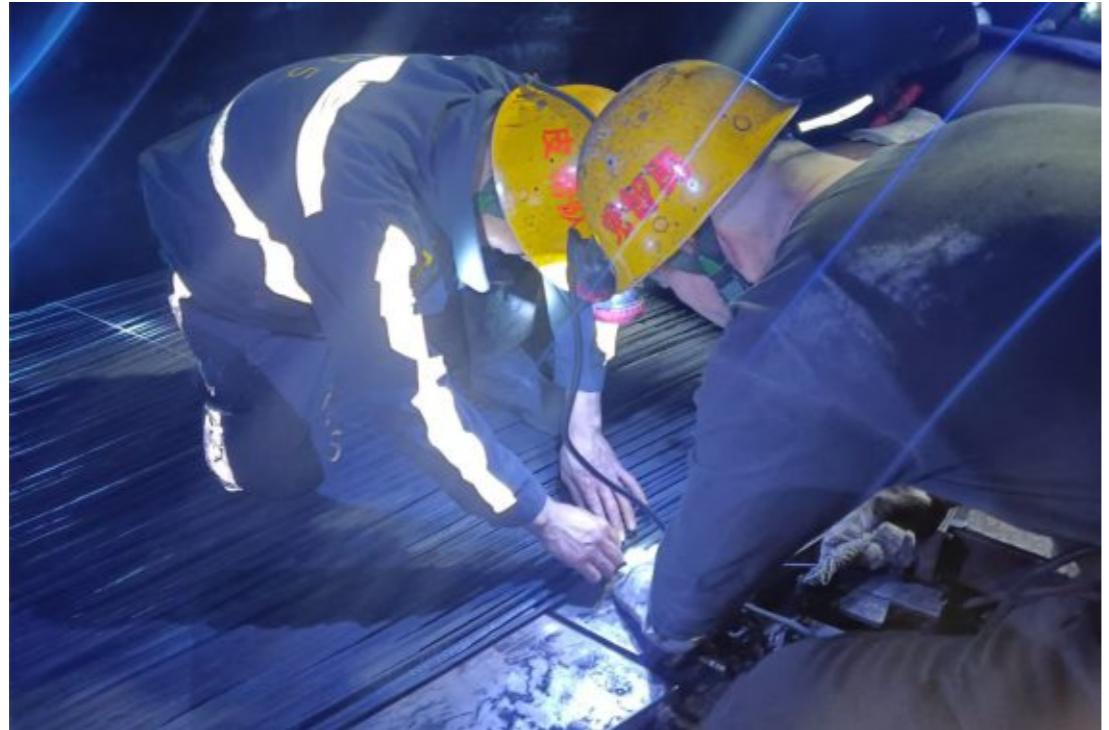
“温度和压力是影响皮带硫化效果的关键因素，大家要注意硫化工艺和现场作业安全，不能出任何差错……”皮带硫化现场，跟班队干提醒道。
