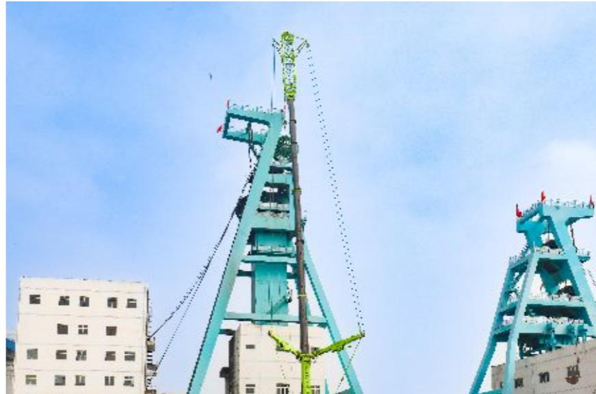
如火如荼。主立井上，作业人员如同身手矫健的“蜘蛛侠”，精准拆卸旧天轮连接部件。地面上，起吊设备驾驶员全神贯注地操控，巨大的起重臂精准就位，时刻准备承接从天而降的“重任”……现场作业人员通力
