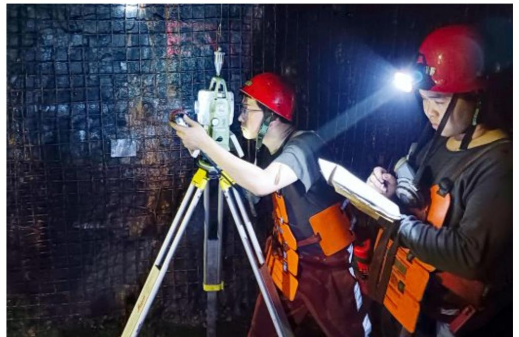
工程进度和施工质量。贯通前，该矿技术人员严格按照《煤矿测量规程》要求，对巷道进行多次复测、校对和数据验算，超前进行贯通误差预计，每班施工前落实技术交底，经实测贯通点水平误差32mm，高程误差仅18mm，贯通精准度远高于《煤矿测量规程》允许的误差范围，实现安全精准贯通。
