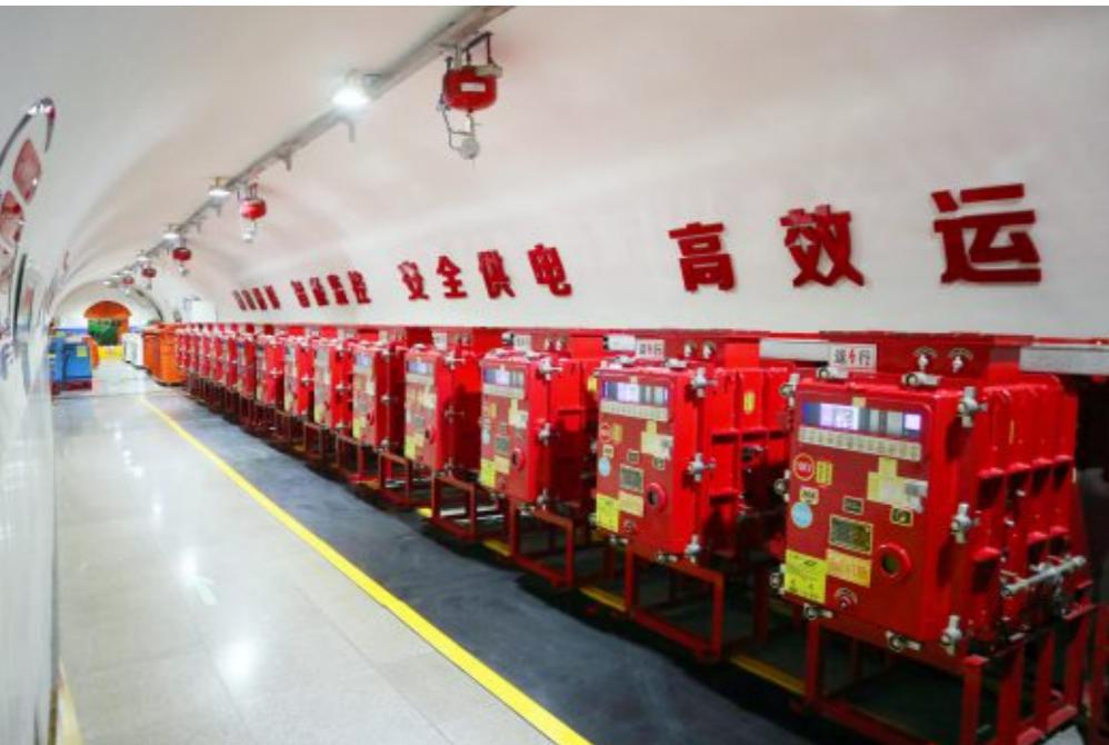
开关进行1次漏电试验。之前，采用传统的人工操作方式每天对低电压馈电开关漏电保护装置进行跳闸试验，试验后再逐个进行恢复供电，操作繁琐、效率低，恢复供电时间长，而且还存在操作失误或遗漏的风险。该系统投运后，操作人员每天只需在地面电力集控系统的界面点击“漏试”按钮，就可完成对402采区变电所低压馈电开关漏电跳闸试验，有效避免了人为原因造成开关漏
