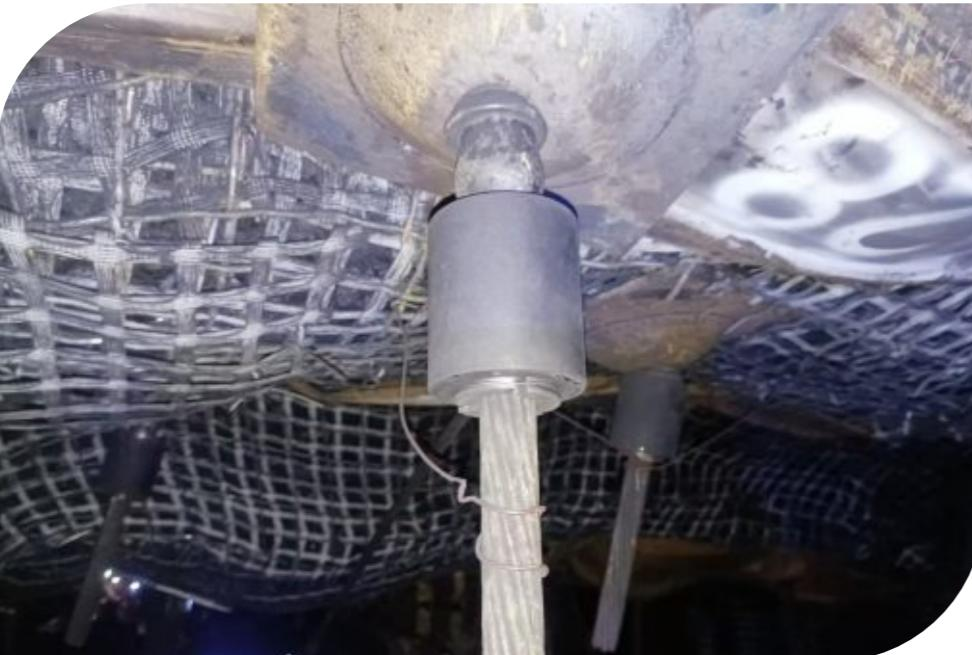
长了支护材料的使用寿命。此外，锚索让压环的安装过程简便快捷，不需要特殊的设备和工具，为工作面单进提升提供了有力保障。
