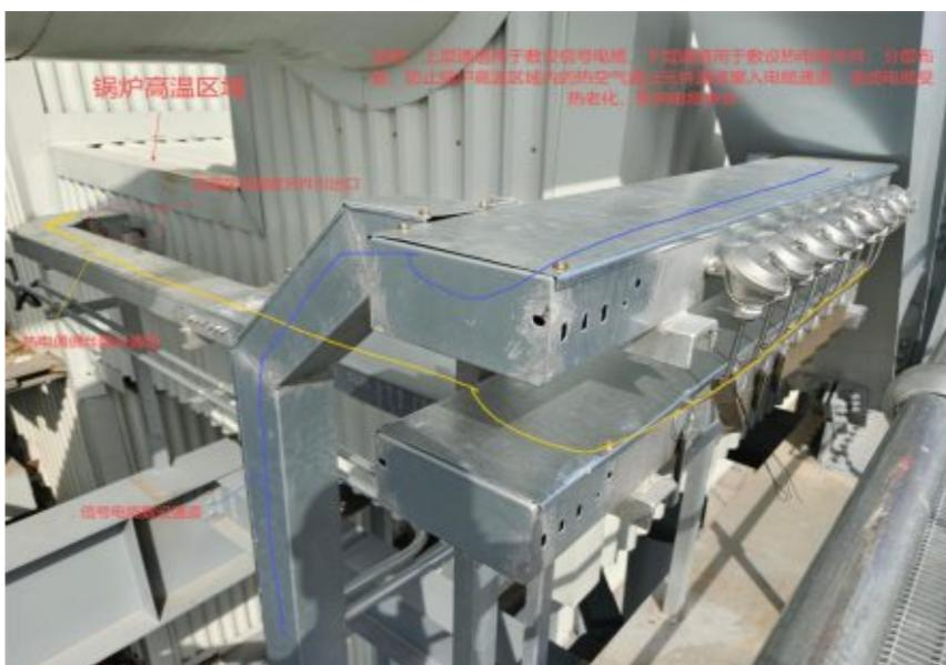
顺着通道肆意乱窜，金属铠装部分更像“导热利剑”，双重夹击下，电缆绝缘层加速老化，进而影响温度“情报”的准确性。
