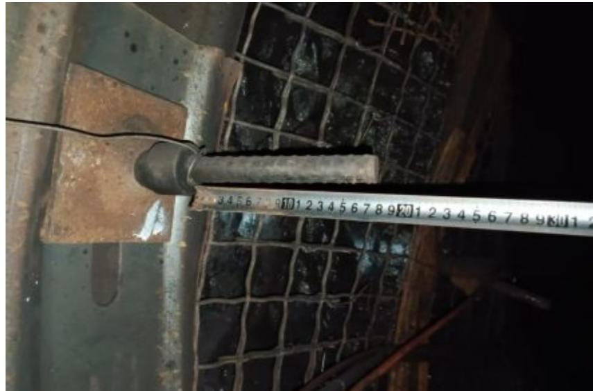
具体内容：小庄矿40208胶带顺槽帮部原采用Φ21.8×3500mm锚索进行支护，间排距1000×900mm，每排4根锚索，5月份170m巷道帮部共计施工锚索1511根，每套锚索材料成本183.88元，材料成本共277842元。为优化巷道支护，提高锚杆支护效能，提升施工效率，节约成本，该矿在满足支护条件的情况下，采用张拉式高预紧力长锚杆支护，将帮部第二、三、四根Φ21.8×3500mm锚索优化为Φ22×3500mm的螺纹锚杆。
