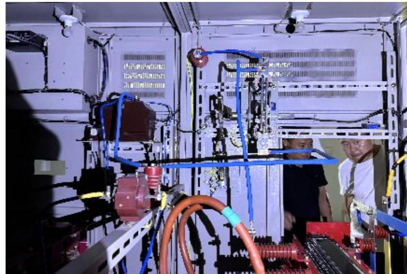
具体内容：电力公司文家坡35kV站的站用变设在35kV电源侧，在遇到雷击情况时，易导致变电站瞬间失压或停电，影响变电站的安全运行。该站用变自2016年投运以来，已累计发生8次故障。电力公司结合实际情况，借鉴三圈变压器运行特性，将10kV消弧线圈成套装置内的接地变压器容量扩大，再出一个380V电源，配备相应380V低压电缆即可，便升级为“接地变兼站用变”，起到“一机两用”的效果，避免新增变压器的同时，保障供电安全高效。
